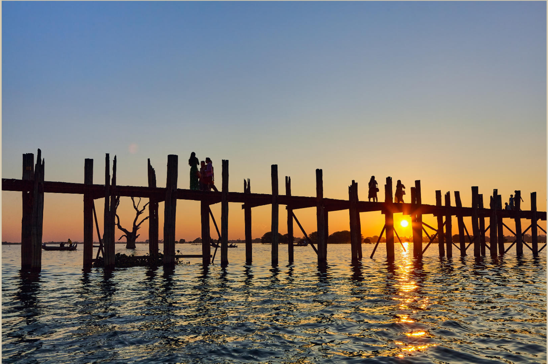
U-Bein Brücke, Myanmar Oktober 2015
