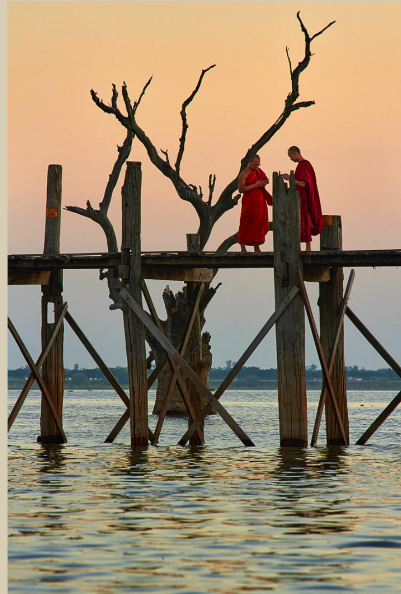
U-Bein Brücke, Myanmar Oktober 2015
